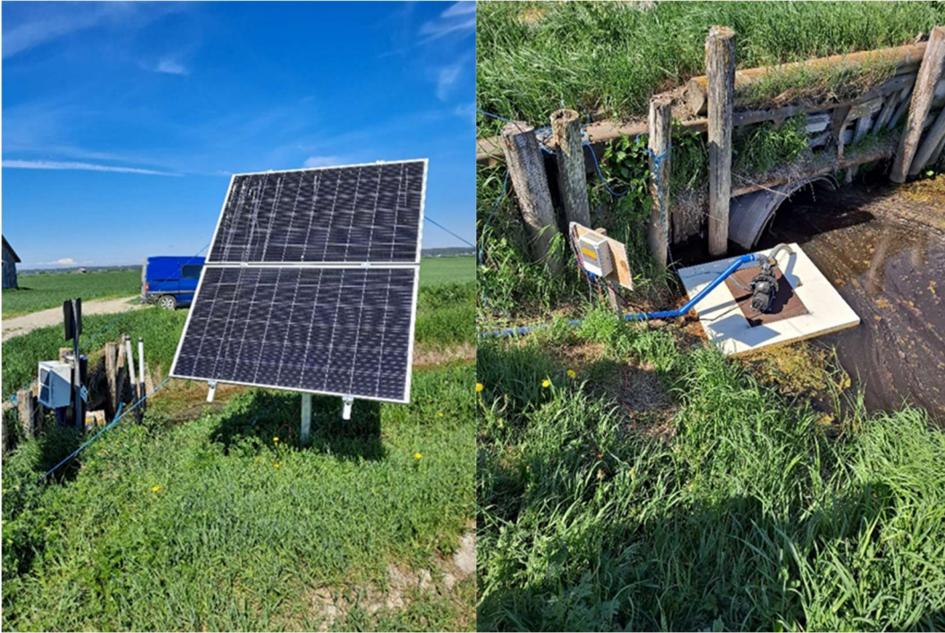
Bild 7: Solcellsdriven pumpanläggning monterades till skifte 1 under våren 2021. Foto Simon Nässlin
