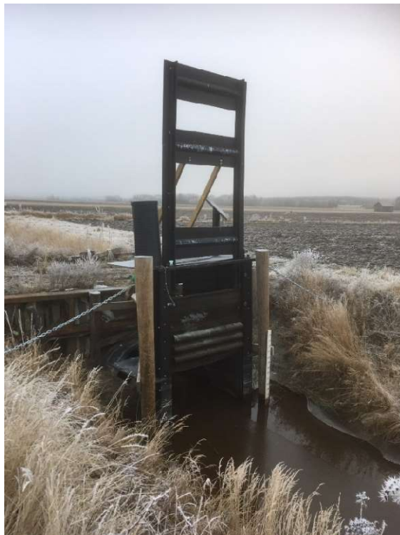
Bild 5: Bild till vänster: I maj 2020 var vattnet i södra Nackdiket så högt att vatten flödade ut via överflödsluckor. Foto: Anna Bonde. Bild till höger: Till vintern och vårfloppet lyfts dammluckan helt upp ur fåran och utfallet fungerar normalt. Foto: Simon Nässlin.
