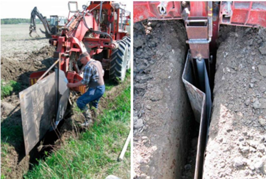
Bild 4: En plastfilm har monterats kring åkerskiftena på Söderfjärdens försöksfält. Foto: Rainer Rosendahl.
